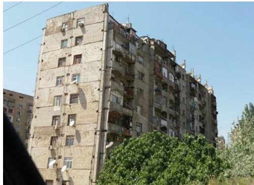
Şəkil 25. Xətai rayonu, Nəsrəddin Tusi küçəsi 224/228 ünvanındakı 16 mərtəbəli panel bina
