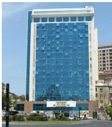
Şəkil 9. 16 Mərtəbəli sərt armaturlu monolit dəmirbeton bina
