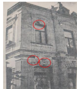
Şəkil 21. Arxeologiya muzeyi yerləşən binada zədələr (Xarici üzlük divar layında daşların qopması)
