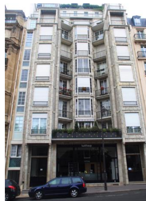
Şəkil 10. Fransa, Paris, Benjamin Franklin küçəsi, 25 ünvanı - 8 mərtəbəli monolit dəmirbeton bina
